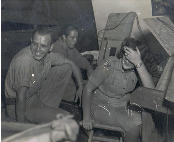
Met Joep bij de nevelconstructie
